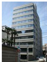
伊藤忠丸の内ビル (名古屋)
