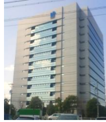
日本ガイシ(株)本社ビル
