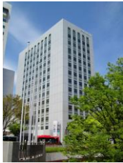
浜松第一生命日通ビル
