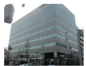
県信松本深志ビル
