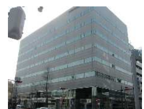
県信松本深志ビル
